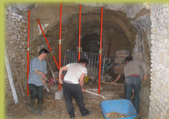
Les habitants réalisent les premiers travaux - Local residents conducting the early work - Los habitantes realizan los primeros trabajos - 2006
